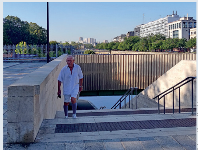
Bande d'éveil à la vigilance, au droit d'un escalier et double main-courante, place de la Bastille
