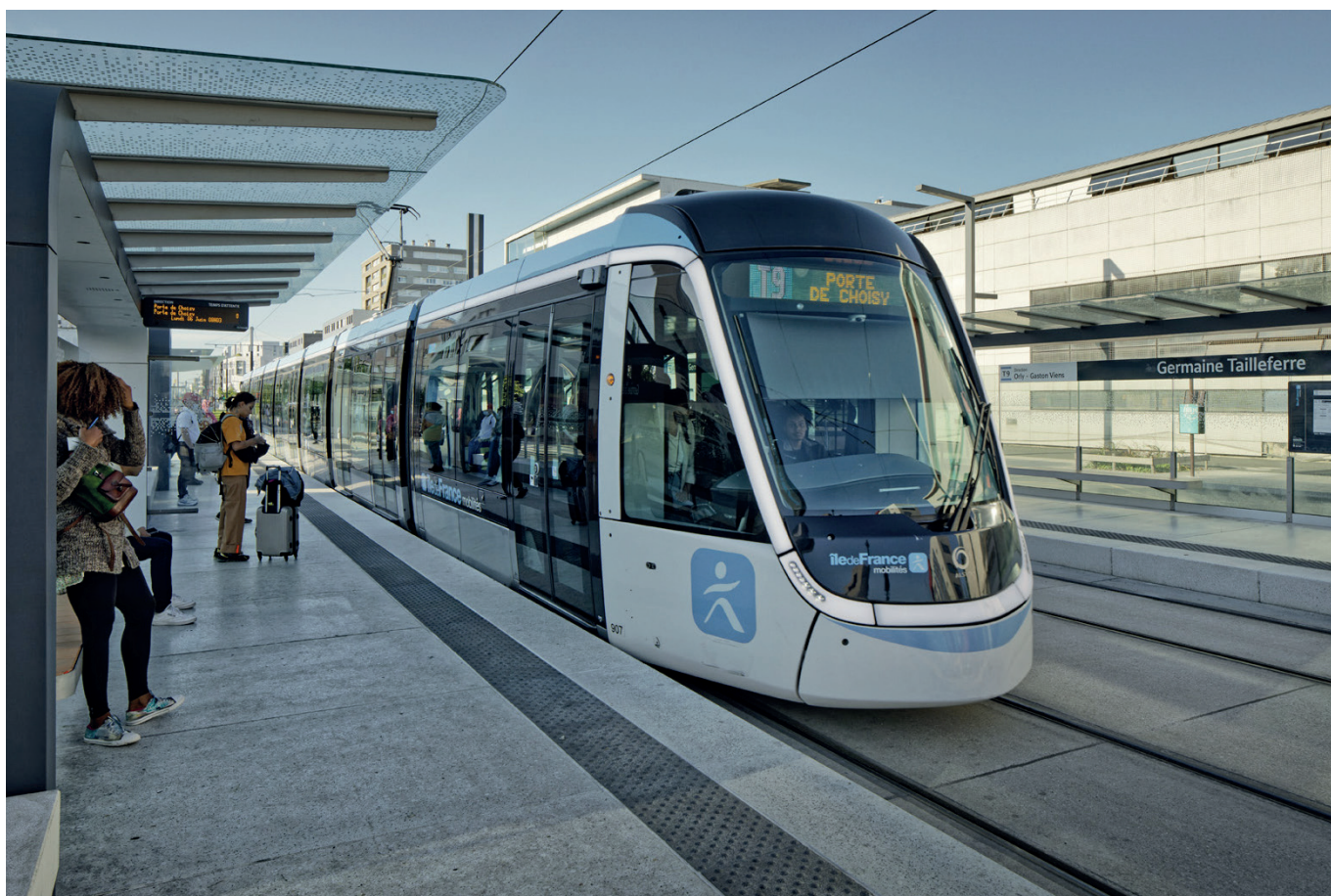
Station de Tramway T9 à Vitry-sur-Seine
