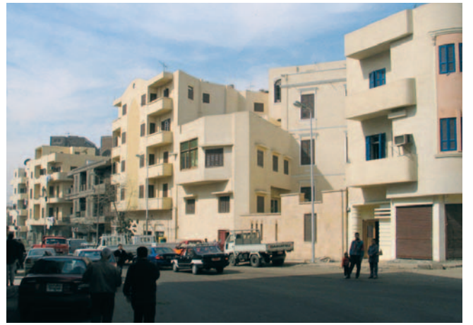
بعد الترميم après les travaux
