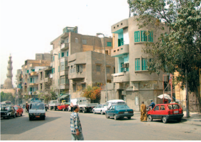
قبل الترميم avant les travaux
