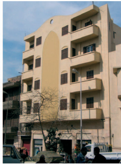
بعد الترميم après les travaux
