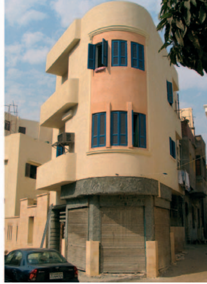
بعد الترميم après les travaux
