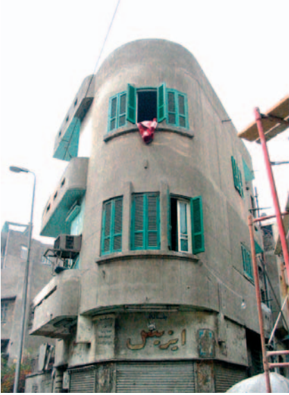
قبل الترميم avant les travaux
