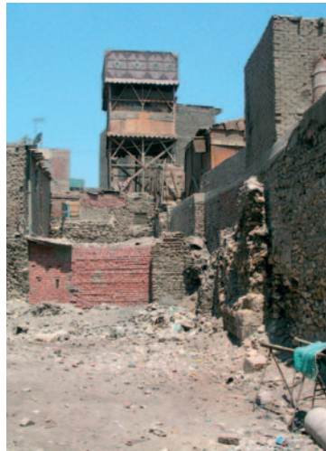
درب القطايعه Darb al-Qatai'a
