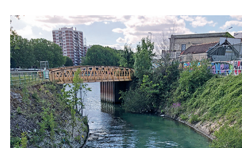
Franchissements de la Vieille-Mer : RER et chemin de halage de la Seine
