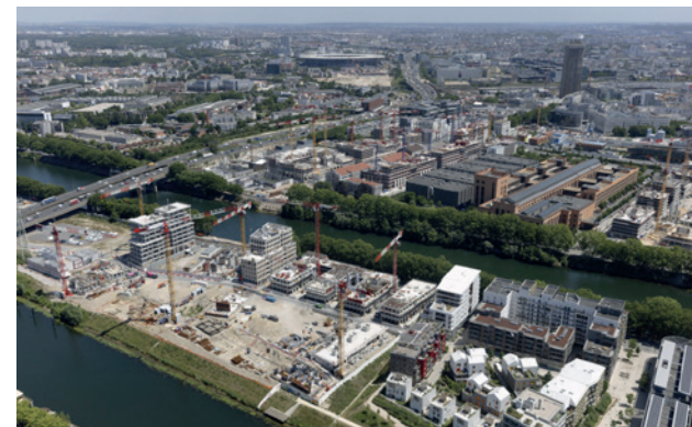
L'Écoquartier Fluvial et le village olympique en construction - L'Île-Saint-Denis
