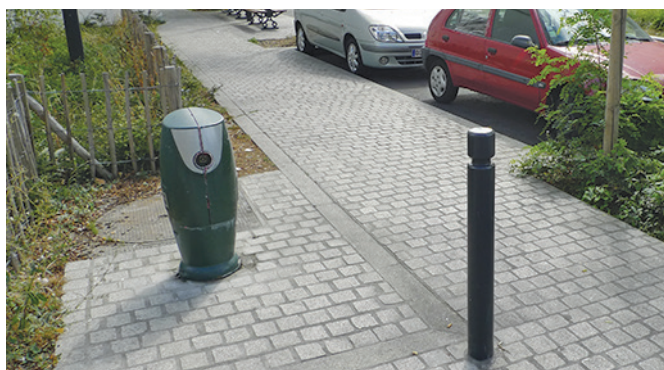
Borne de service à proximité du canal Saint-Denis, alimentées en eau potable
