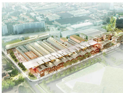
Halles Babcock - La Courneuve
