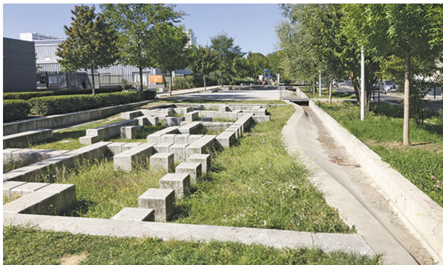
La gestion de l'eau dans le quartier des 4 000 Nord à La Courneuve. Une réponse de qualité aux effets des remontées de nappes et de l'ancien cours du ru Saint-Julien (agence ATM)
