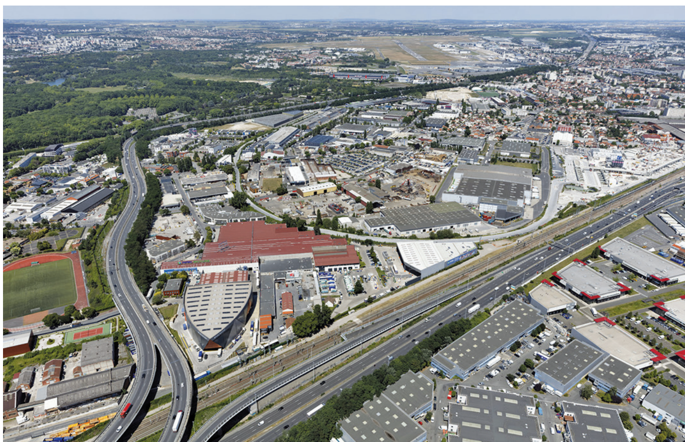
Continuités et discontinuités des paysages autoroutiers. Un potentiel à renforcer. Raccordement A86/A1, secteur d'activités économiques Jean-Mermoz - La Courneuve
