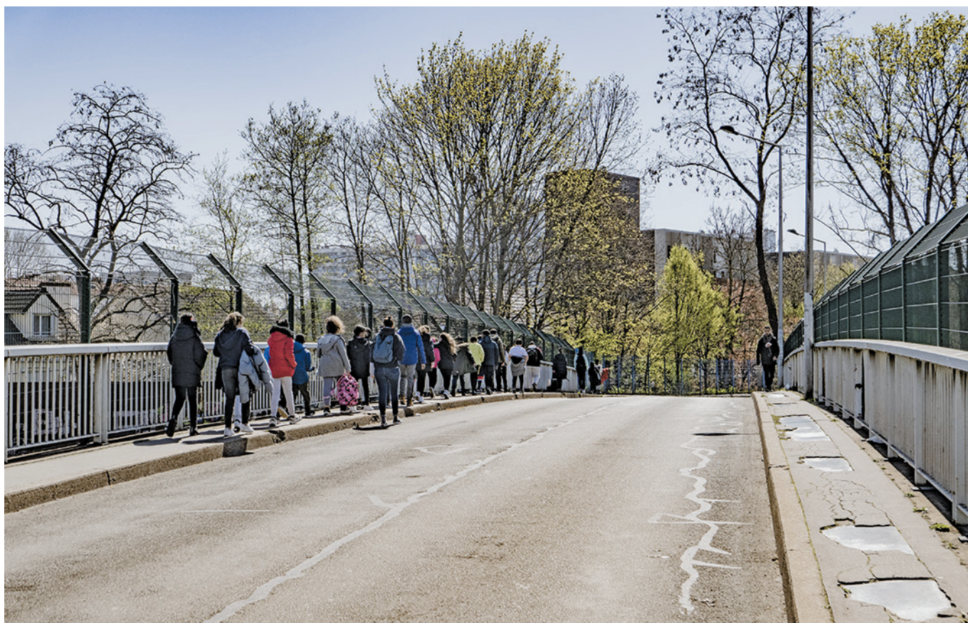
Les franchissements, des opportunités de point de vue et de partage des mobilités. Pont de la rue Voltaire, au-dessus de l'A1 - Saint-Denis
