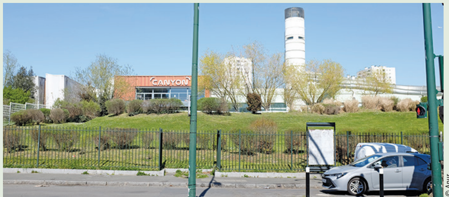
Espaces extérieurs de la piscine Canyon, Épinay-sur-Seine
