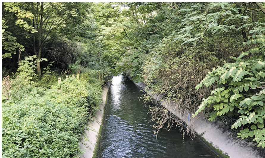
La Vieille-Mer amont, un canal à ciel ouvert couvert par la végétation, une renaturation à poursuivre
