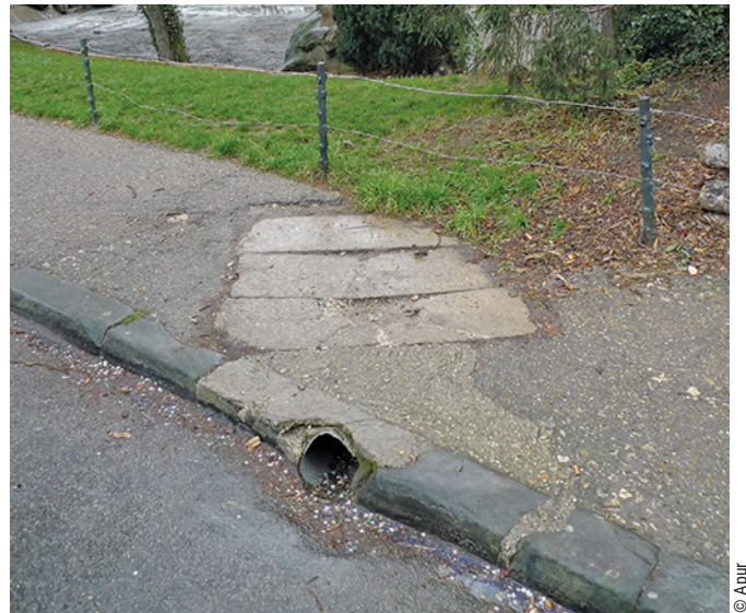
Puisards rectangulaires et cylindriques permettant l'infiltration sous trottoir ou chaussée des bois parisiens (Alphand, Les promenades de Paris, 1867-1873) et exemple de dispositif toujours en vigueur
