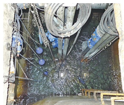
Les eaux d'exhaure du parking Basilique: trappe d'accès et poste d'épuisement
