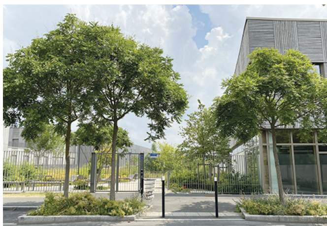
Vue de l'emprise d'Urban Valley en lien avec l'aménagement du parvis de la gare T 11 - Stains
