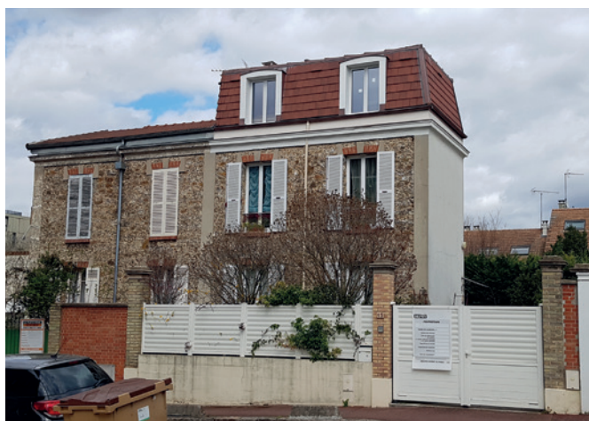
Deux pavillons jumeaux datant des années 1920, le pavillon de droite, initialement conçu avec une toiture à faible pente, a été surélevé pour créer un comble habitable, Nanterre
