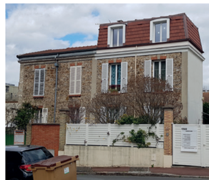
Transformation d'une toiture de faible pente en un toit à la Mansart, rue Joseph Terneau, Nanterre
