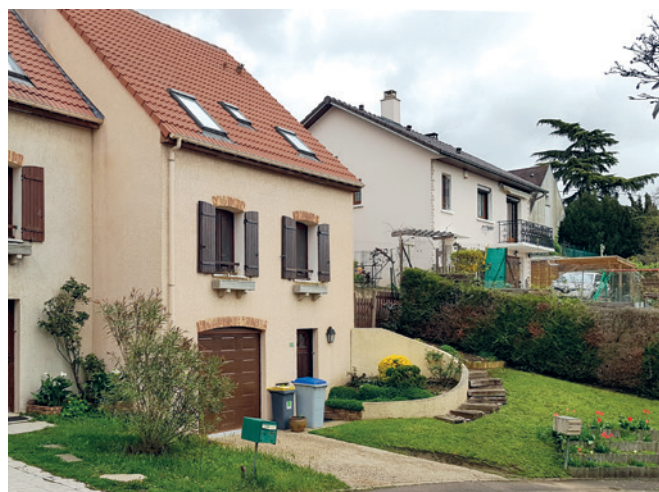
Pavillon d'une opération groupée des années 1990 à Montfermeil. Le pavillon est isolé par l'intérieur. Il comporte des volets en bois qui protègent efficacement du soleil les chambres du 1 er étage. En revanche le comble habitable est sujet à la surchauffe notamment à cause des fenêtres de toits sans protection solaire extérieure. La pièce semi-enterrée présente dans les typologies plus anciennes a disparu.
