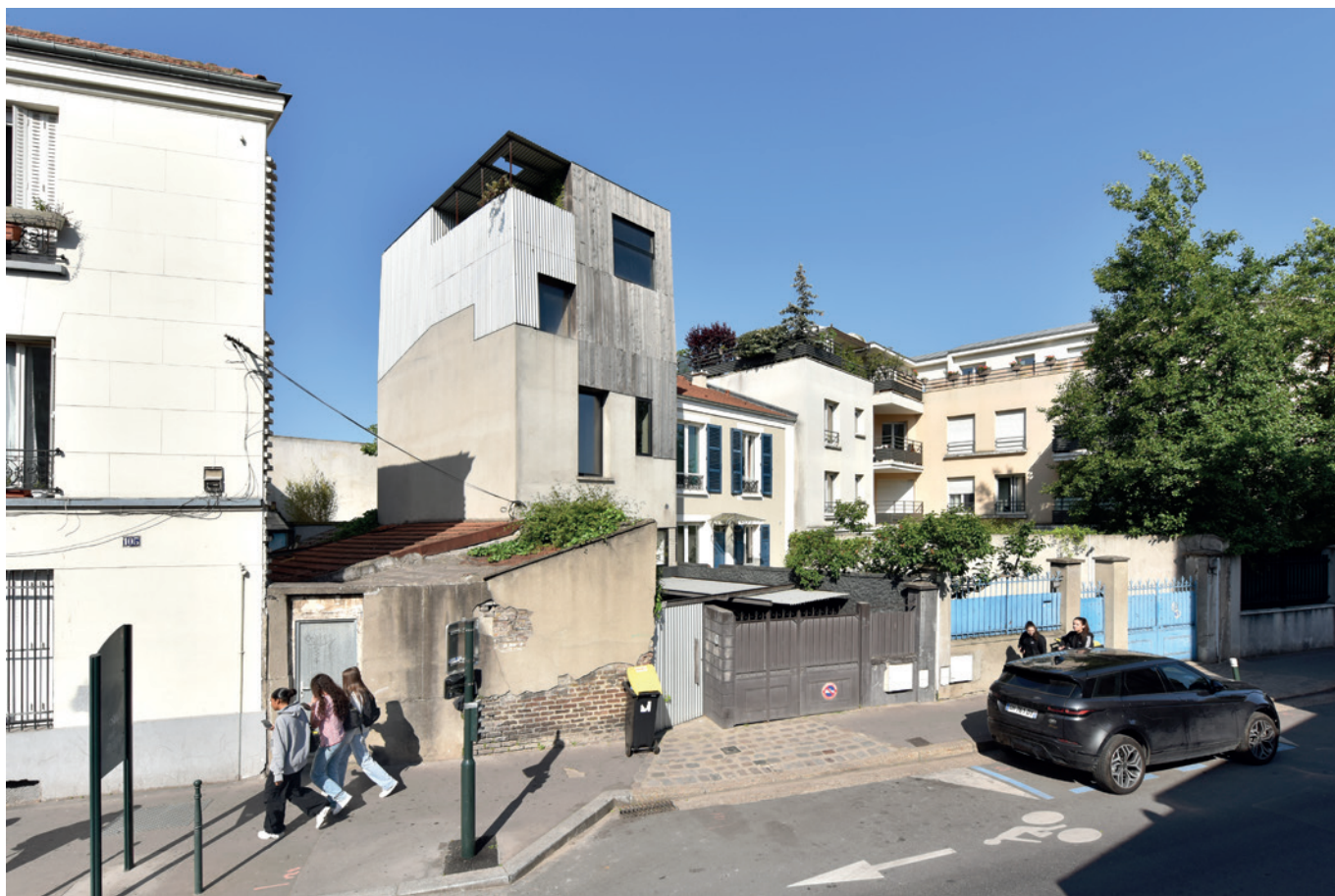
Surélévation d'un pavillon ouvrier, rue du Ménéil, Asnières-sur-Seine
