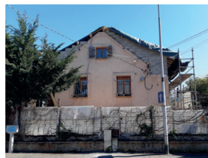
Augmentation de la hauteur sous comble sans modification de la hauteur du faîtage, Le Blanc-Mesnil
