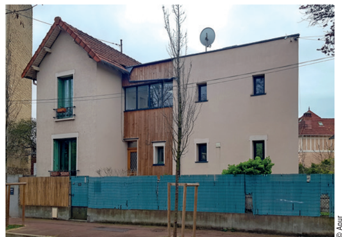
Pavillon des années 1930 avec extension en R+1 avec isolation thermique extérieure (ITE), la surface habitable augmente considérablement à la suite de l'extension du pavillon, Rueil-Malmaison
