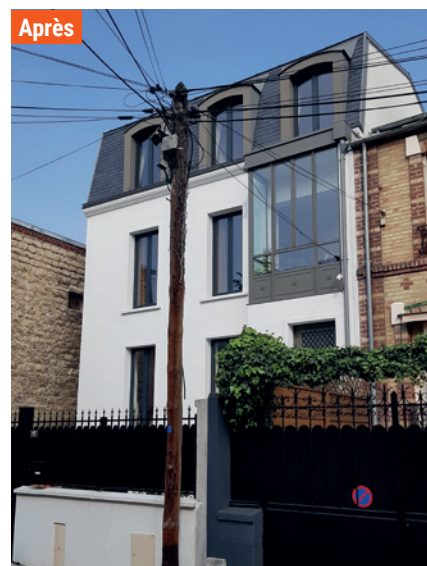
Opération de surélévation et extension, avec création d'une travée supplémentaire et d'une mansarde, la totalité du bâtiment est isolée par l'extérieur (ITE) à l'exception du toit, Asnières-sur-Seine
