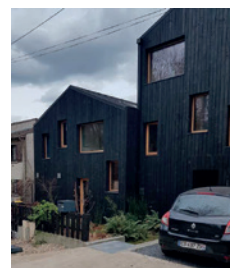
2019 Pavillon avec isolation extérieure et bardage bois (RT2012)
