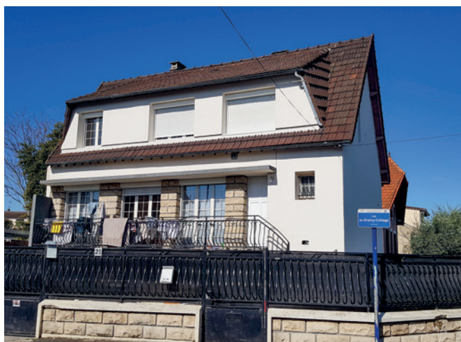
L'isolation extérieure est mise en œuvre sur toutes les portions de murs initialement enduites : par exemple la lucarne de l'étage sous comble, ainsi que les pignons. Au rez-de-chaussée, la pierre de parement interdit partiellement l'isolation extérieure : pour des raisons esthétiques, mais aussi pour des raisons pratiques puisque l'épaississement des piliers de pierre rendrait impossible l'ouverture de la porte d'entrée et des baies vitrées.
