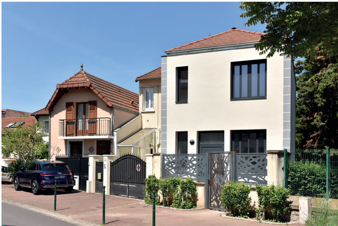
Grand pavillon construit en remplacement d'un pavillon de plus petite taille, rue Jules Parent, Rueil-Malmaison
